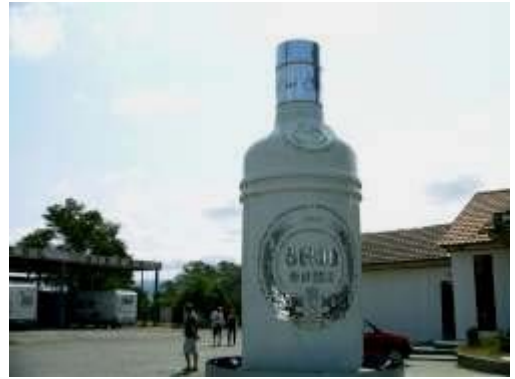
Fabbrica di vodca - Gomi (GE)
